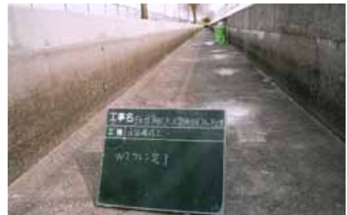
超高压水ケレン後
