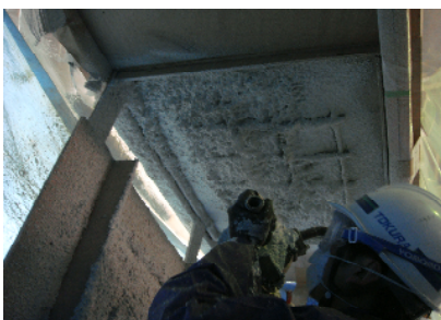
天井面への吹付け状況
