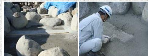
①施工前 ②表面処理工(ディスクサンダーによる)
