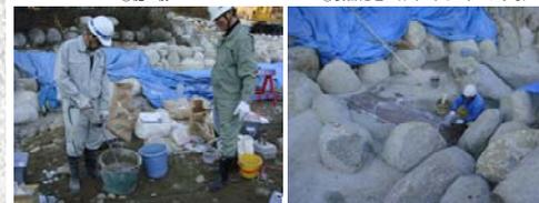
③ハンドミキサーにより材料混練り ④左官工による増厚
