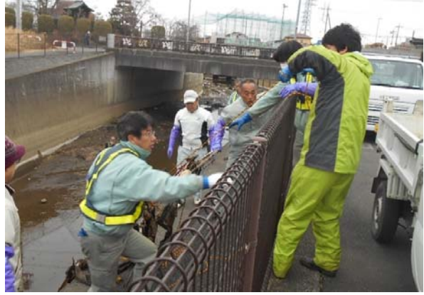
籠で水路内のゴミを引き上げ中！
