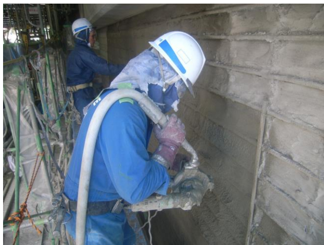
PREE 工法によるモルタル増厚状況
