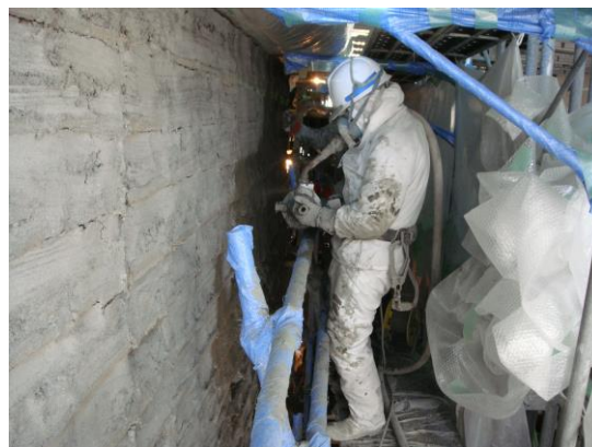
PREE 工法によるモルタル増厚状況
