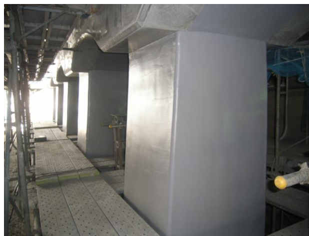
モルタル増厚完了
