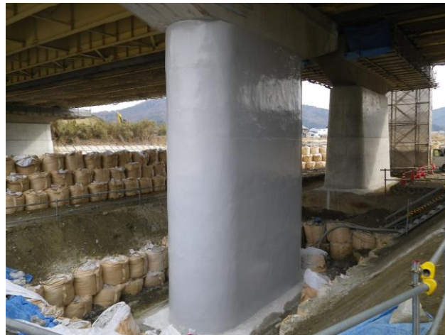
モルタル増厚完了
