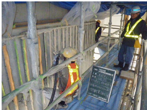
PREE 工法によるモルタル増厚状況
